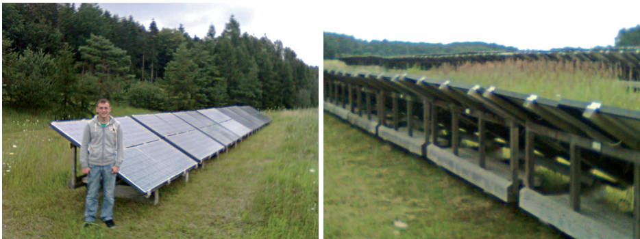
Joonised 1 ja 2. Grevesmühlen GmbH päikeseplatade park Photos 1 and 2. Grevesmühlen GmbH solar panel park
