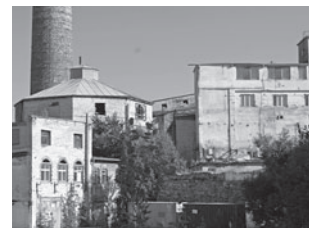
Kultuurikatel. Cultural boiler.
