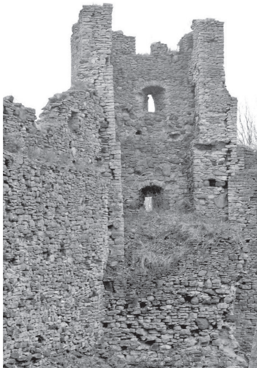
Poolkuutorn enne restaureerimist. Torniruum oli kaetud paksu pinnasekihiga, müüritise äärekivid lahti. Foto – Tõnis Padu
