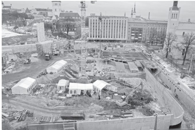
Arheoloogilised uuringud Vabaduse väljaku rekonstrueerimistööl. Väljakaevamised kiviaja asulakohal kestsid 2008. a juulist 2009. a märtsini; seoses ebasoodsate ilmaoludega (vihm, lumi, pakane) toimus töö enamiku ajast telkides
