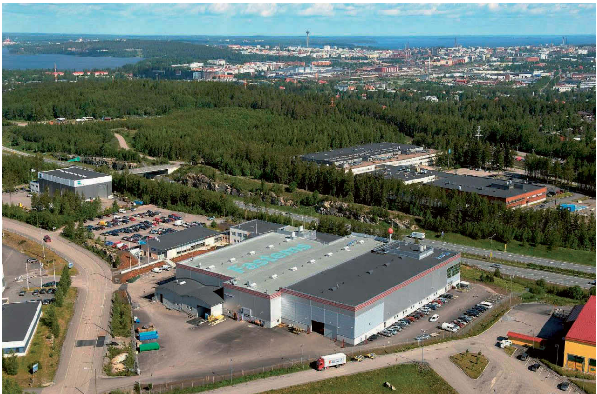
Joonis 1.1. Tööstusettevõtte üldvaade
