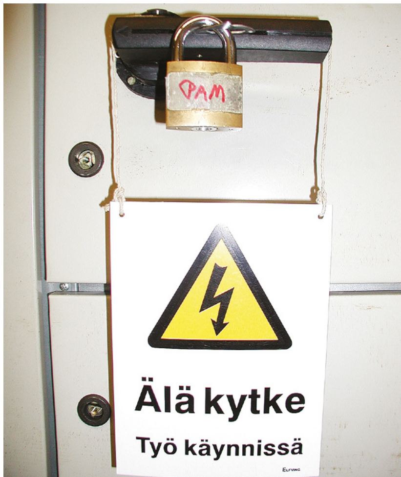
Joonis 21.3. Masina toiteahela lahkülülitit peab olema võimalik lukustada AVATUD asendisse.
