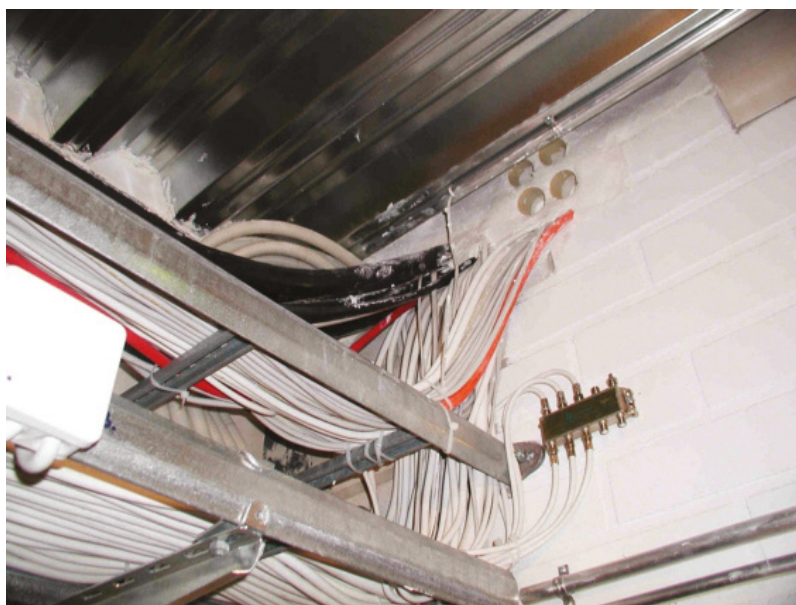
Joonis 24.2. Kui seinal nähakse ette teatav tulekindlusklass, siis kaabli paigaldamine ei tohi seina tulekindlust vähendada.
