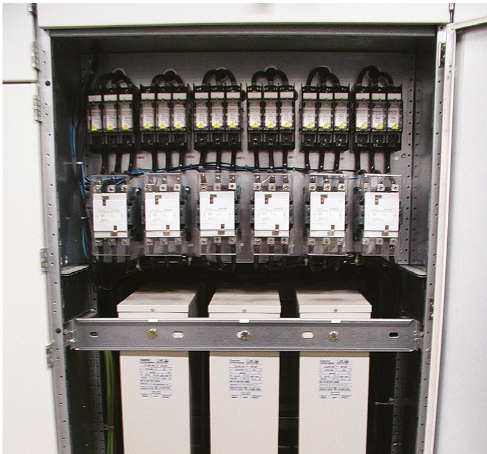
Joonis 21.7. Ohtliku jääkpinge kõrvaldamine peab olema tagatud
