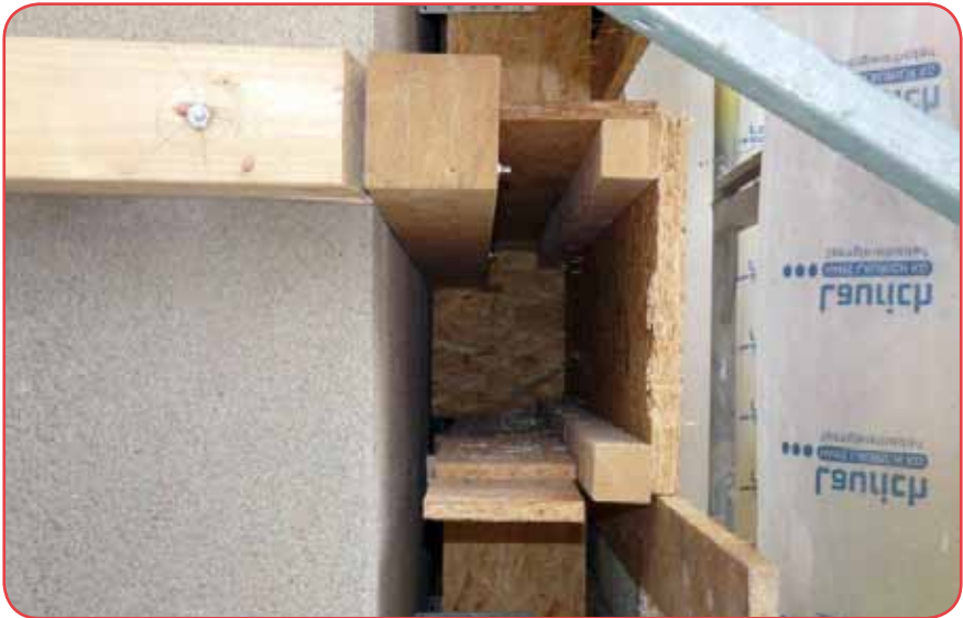
Joonis 5 Spetsiaalne puitraamistik hoone välisseinal täidetakse hiljem isolatsioonimaterjaliga | Pilt: © Jörg Faltn
