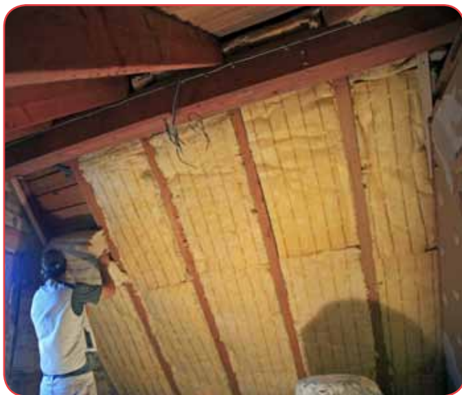
Joonis 6 Soojustuse lisamine sarikate vahele vähendab soojuskadu katuse kaudu Pilt: © Rainer Sturm | PIXELIO.
