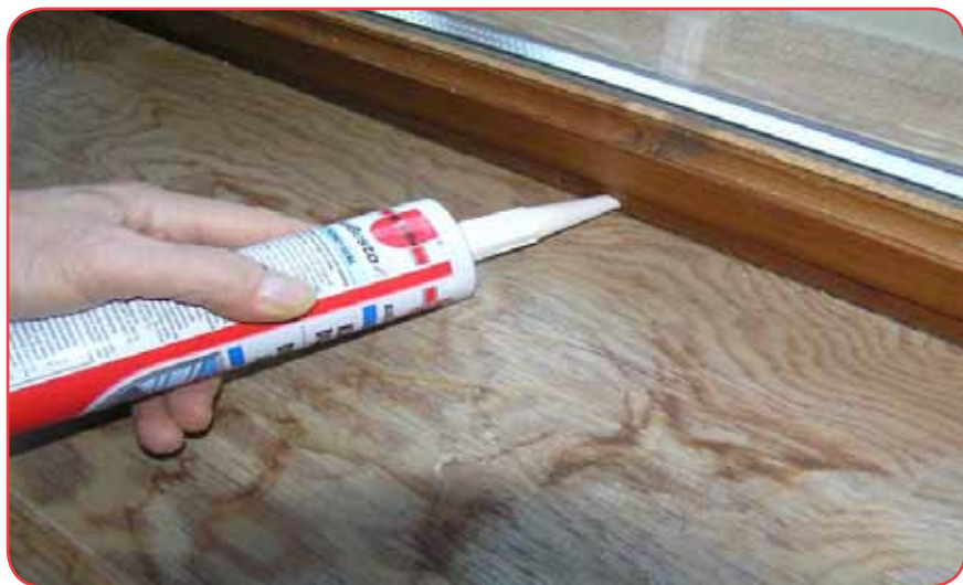
Joonis 3 Hermeetiku paigaldamine aknaraami pragudesse
