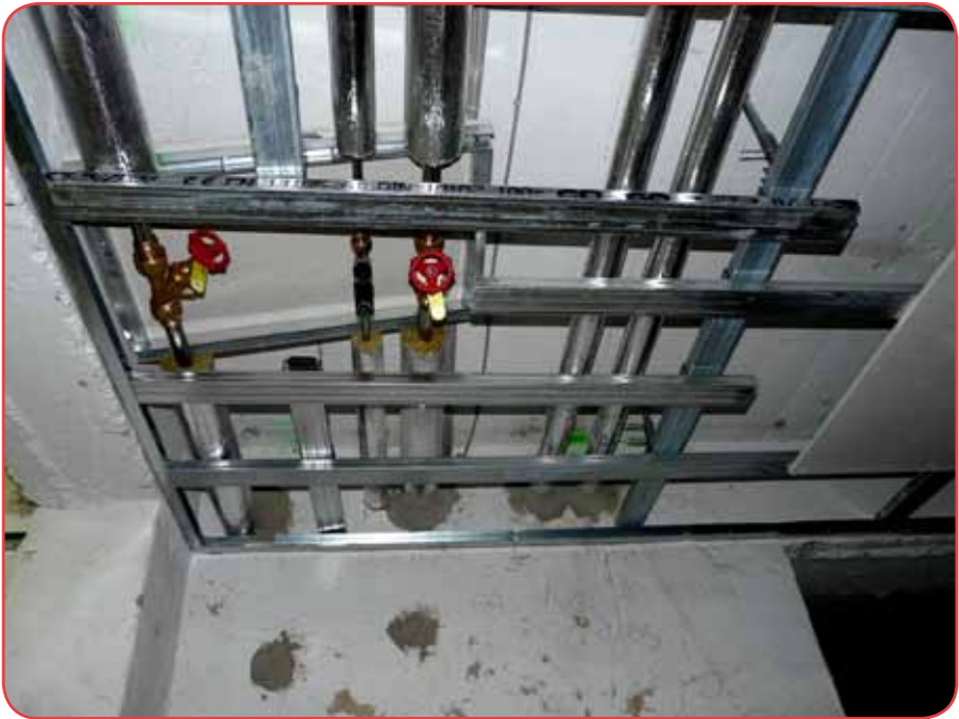
Joonis 7 Ettevalmistused keldri lae soojustamiseks on tehtud Pilt: © Jörg Faltn
