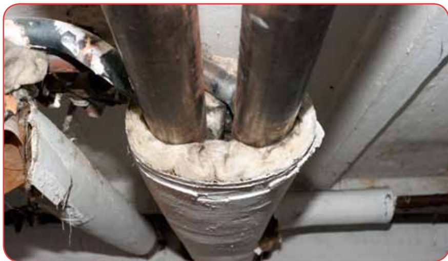
Joonis 1 Küttesüsteemi torude isolatsiooniga tagatakse, et soojus ei lähe enne tubadesse jõudmist kaduma | Pilt: © Philipp Engewald.
