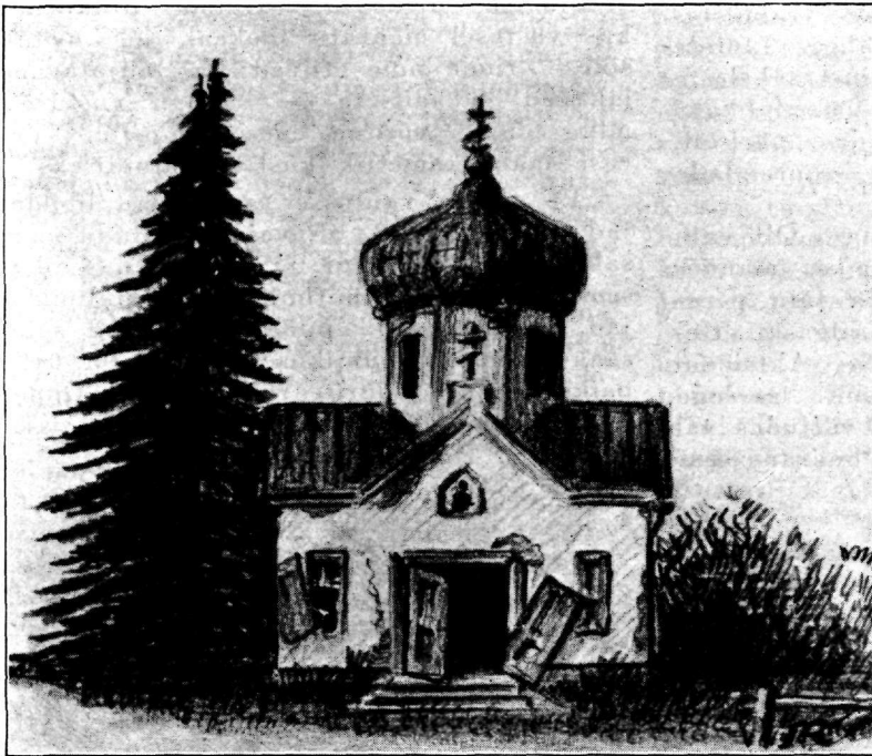
Rüüstatud üksik kabel.
