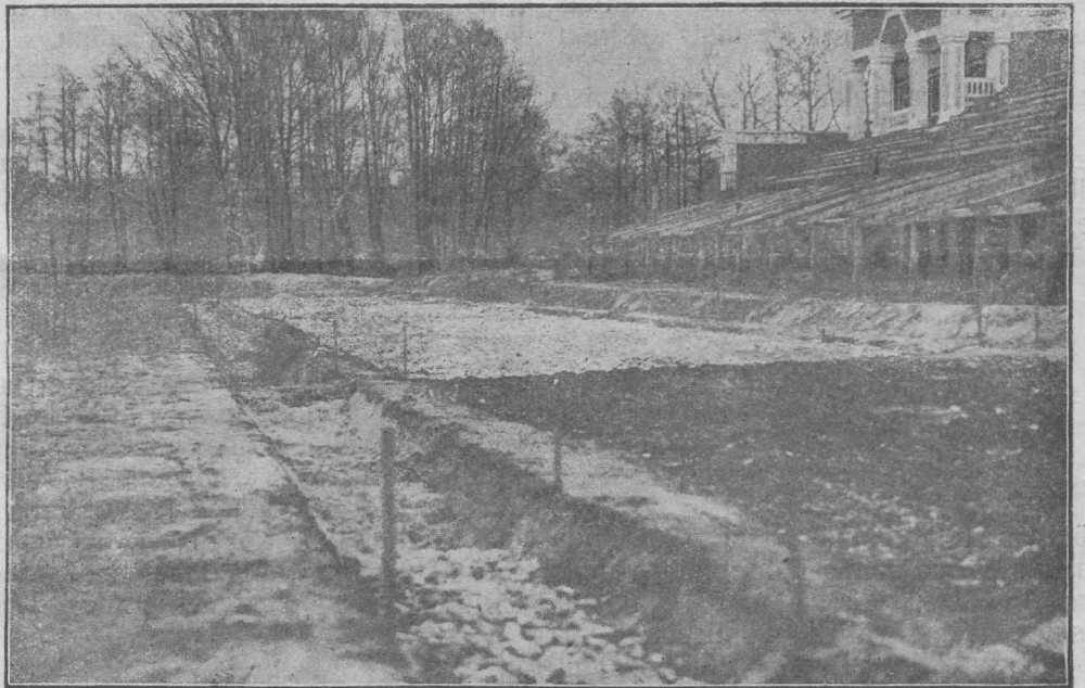
Staadioni jooksutee ehitus: näha jooksutee kihid — vasakul raja alumine kiht, jämeda paekivi puiste (valge), paremal on see kaetud juba shlakiga (must). Eest pikuti läbiminev kraav on kauguse ja kolmikhüppe tee alus.
