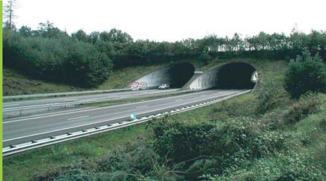
Ökodukt Hollandis on 100 m pikk ja 30 m lai
