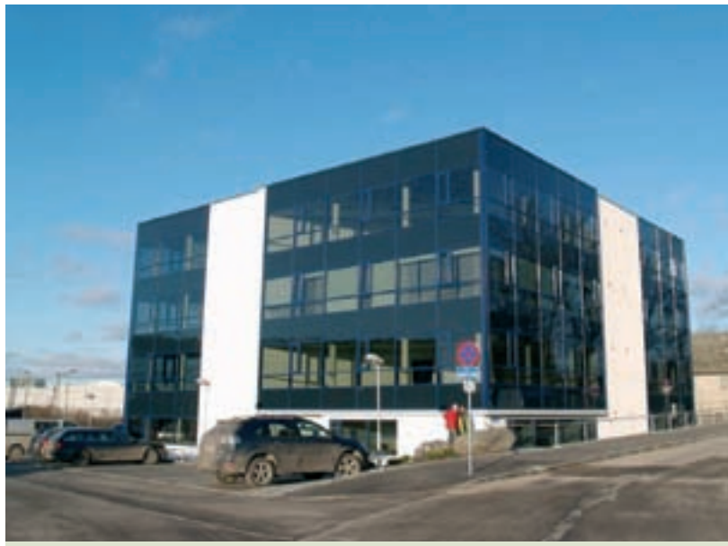
ESIMENE MITMEKORDNE KIUDBETONIST VUNDAMENDI JA VAHELAGEDEGA BÜROOHOOONE TALLINNAS, KOTKAPOJA TÄNAVAL.
