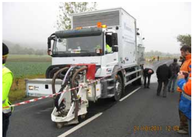
Foto 8. TrackJet-masin suurendamas sõiduraja karedust. Masin kuulub Poola firmale Droppol
