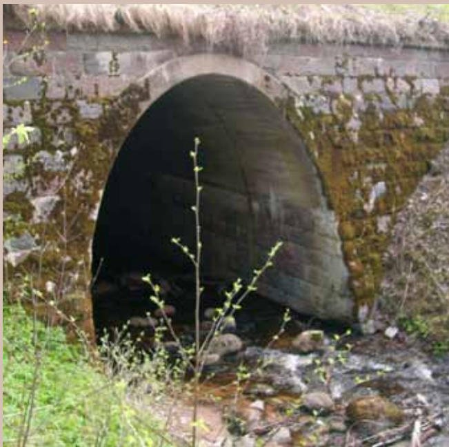
Foto 1. Kolmekuningasild Võrumaal. Tahatud raudkividest ja betoonist võlvisilla ehitamist alustati hädaabitööde korras 1930. aastate lõpus, kuid lõplikult valmis sild 1940. aastal
