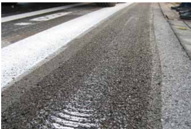
Foto 3. PeelJet iga eemaldatud termoplastmarkeeringust jäänud fantoomjoon. Näha on erinevate töörežiimide tulemusi. Tagapool on joon täiesti kadunud
