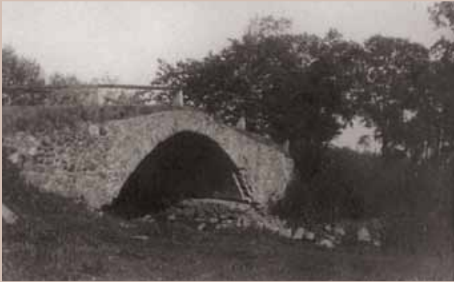
Foto 7. Erakordselt järsu tõusuga raudkivivundamentidel Vastseliina paevõlvsild lammutati 1935. aastal, sest selle ületamine oli muutunud eluohhtlikuks. Foto Eesti Arhitektuurimuuseum
