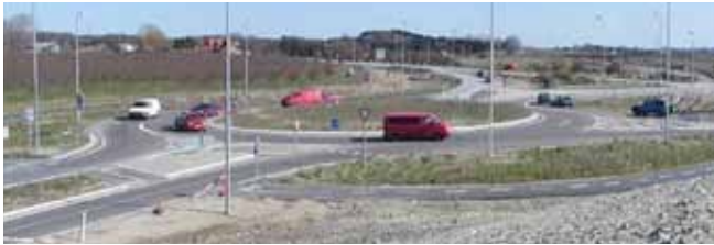
Joonis 3. Uus ringristmik eraldi jalgrattaradadega – ohutu tehniline lahendus
