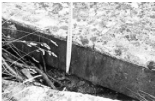
Бронеплита перекрытия убежища зенитной батареи № 509.
