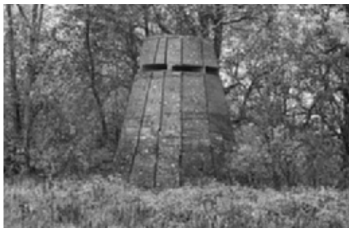
Наблюдательная башня у 1-го артблока 180 мм батареи.
