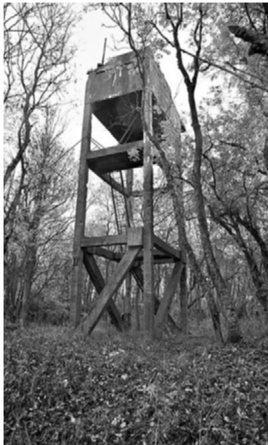
Наблюдательный пост запасного передового командного пункта.
