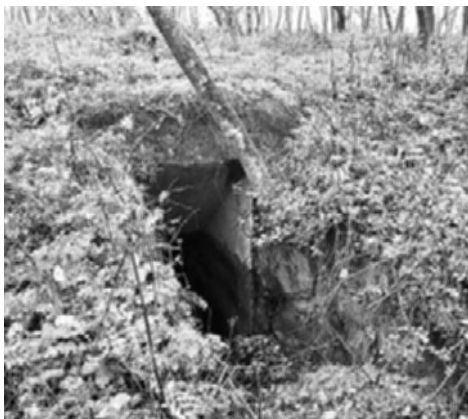
Главный вход в подземный блок командного пункта.
