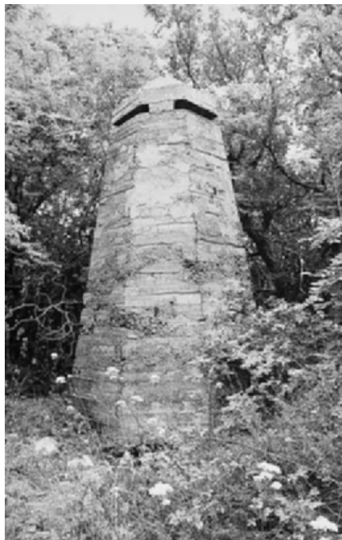
Наблюдательная башня у 2-го артблока 180 мм батареи.
