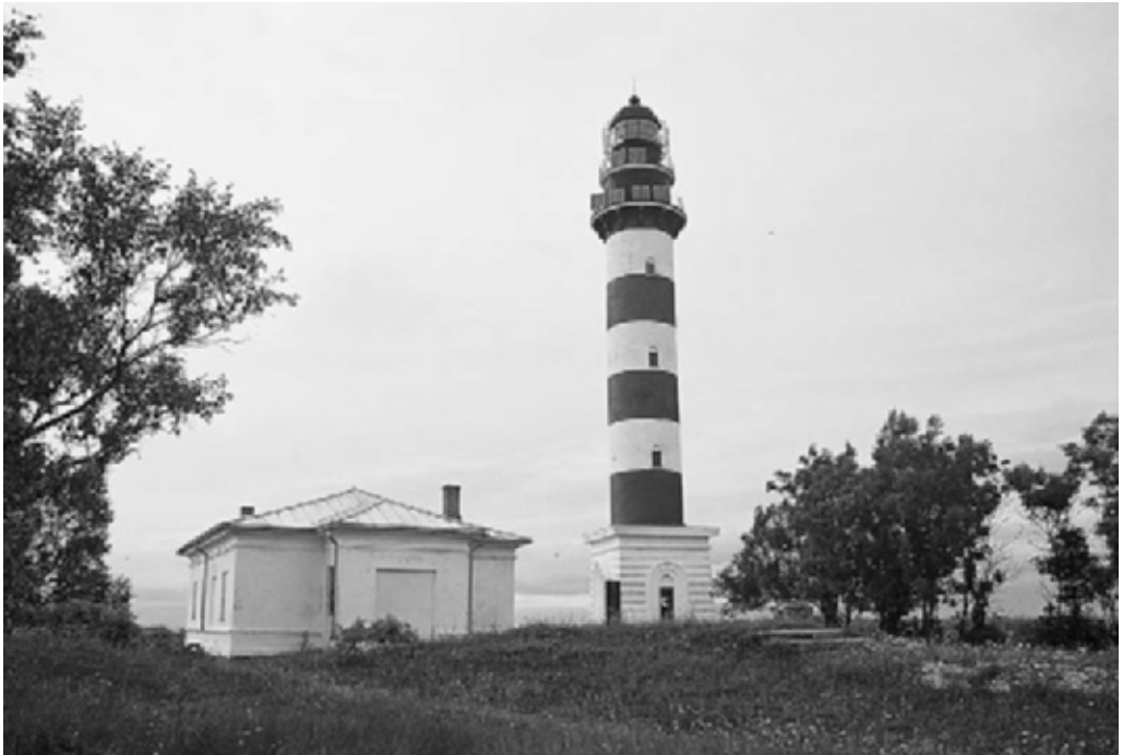
Маяк 1954 г., основание маяка 1850 г. и здание моторной электростанции 1910 г.
