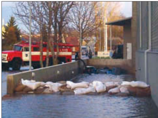
Liivakottidega tõkestatud keldri sissepääs jaanuaritormi ajal Kuressaares.
