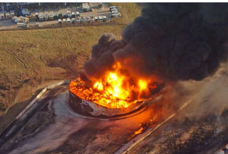
••Pilt 2•• Kütusereservuaaride põlengute probleemsõlm - sissevajanud mahuti seinad nn. taskud.
