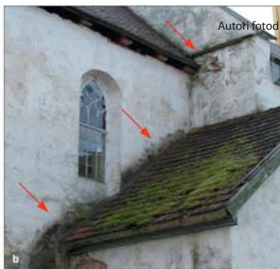
Joonis 11. a Urvaste kiriku idafassaad: katuseviilu katteplekkide veenivad on liiga lühikesed; b Puhja kiriku kooriruum (vaade kirdest): katusele voolav vesi on kahjustanud seina, sest katuse ja seina ühenduskohas pole vihmaveerenni ega seina kaitsvat plekki
