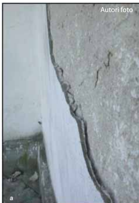
Joonis 7. a Sangaste kiriku käärkambri fassaad; b külmakahjustuse parandamine tsementmördiga põhjustab tavaliselt uue ja suurema kahjustuse [4]
