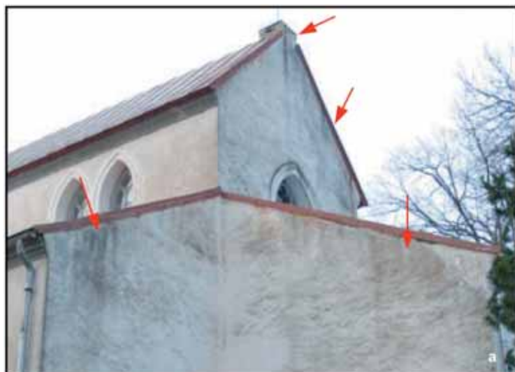
Joonis 11. a Urvaste kiriku idafassaad: katuseviilu katteplekkide veenivad on liiga lühikesed; b Puhja kiriku kooriruum (vaade kirdest): katusele voolav vesi on kahjustanud seina, sest katuse ja seina ühenduskohas pole vihmaveerenni ega seina kaitsvat plekki
