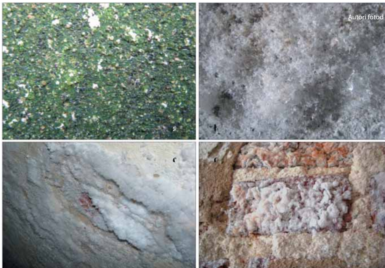
Joonis 8. Lähivõtted: a seinä tihedast vetikakattest; b soolakristallidest krohvi pinnal; c ja d soolakristallidest kivi pinnal
