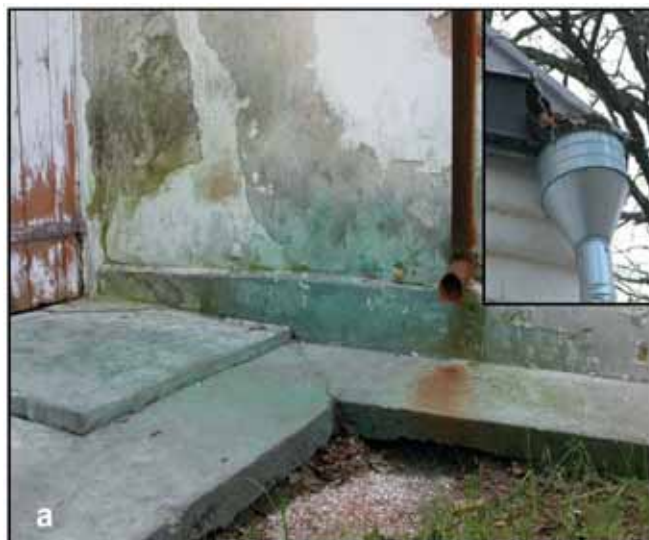
Joonis 6. a Sangaste kiriku põhjafassaadi krohv on määrdunud; b Urvaste kiriku läänefassaad on suvel enamasti varjus, mis takistab kuivamist. Määrdumist põhjustavad ka veekoormust suurendavad puud
