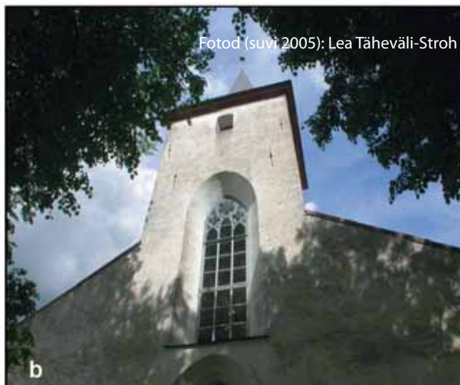
Joonis 6. a Sangaste kiriku põhjafassaadi krohv on määrdunud; b Urvaste kiriku läänefassaad on suvel enamasti varjus, mis takistab kuivamist. Määrdumist põhjustavad ka veekoormust suurendavad puud
