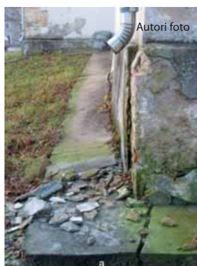
Joonis 3. a Sangaste kiriku sokkel; b vee liikumine vanas hoones (kui põrandale pannakse tihe kate, suureneb vundamenti ja seinte niiskuskooormus; näidatud on vee kapillaartõusu ning soolade liikumist ja ladestumist vanades müüritistes) [4]; c sillutise korral liigub vesi läbi müüritise ning aurustub selle pinnal [5]
