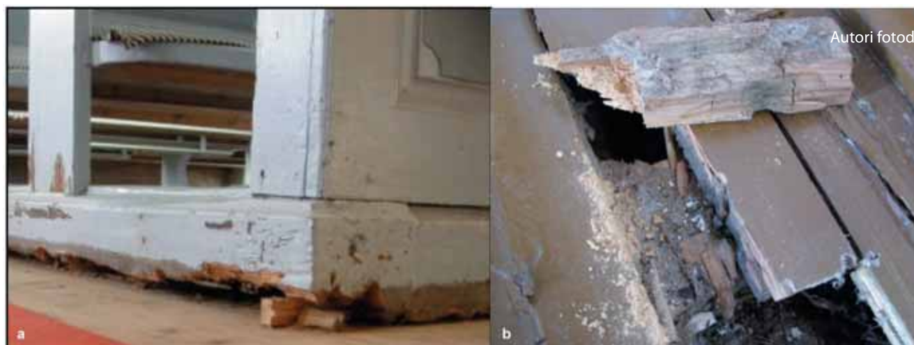
Joonis 5. a Sangaste kiriku pingid on pehkinud; b Rannu kiriku põranda lõunapoolsel osal oli näha seen- ja putukakahjustust
