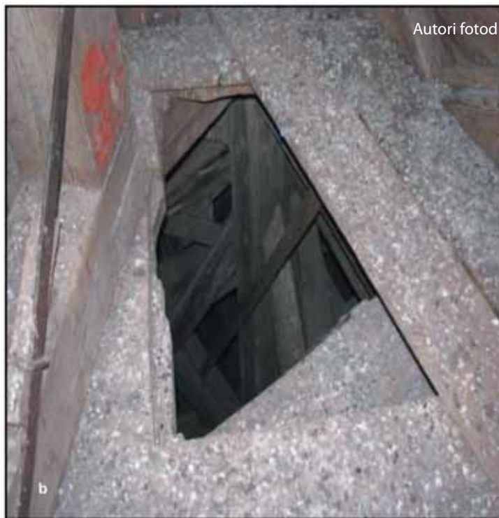
Joonis 9. Sangaste kirik: a katuse tarindid; b torni katab linnusõnnik (Kevad, 2009)
