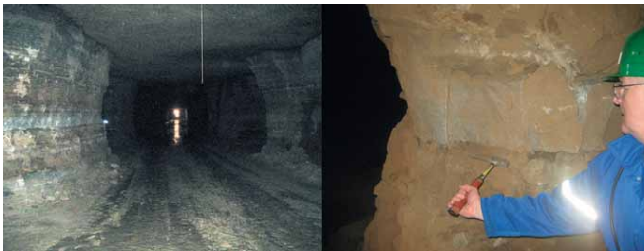
Joonis 7. Tervikud hakkavad purunema külgpinnalt – kaeveõõne lae ja põranda vahelt, keskosast, kuna sinna kogunevad suurimad pinged (Estonia kaevandus)
