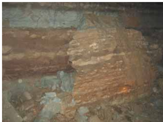
Joonis 8. Pinge nõrgendab terviku pinda ja tervik hakkab kihthaaval murenema (Estonia kaevandus)
