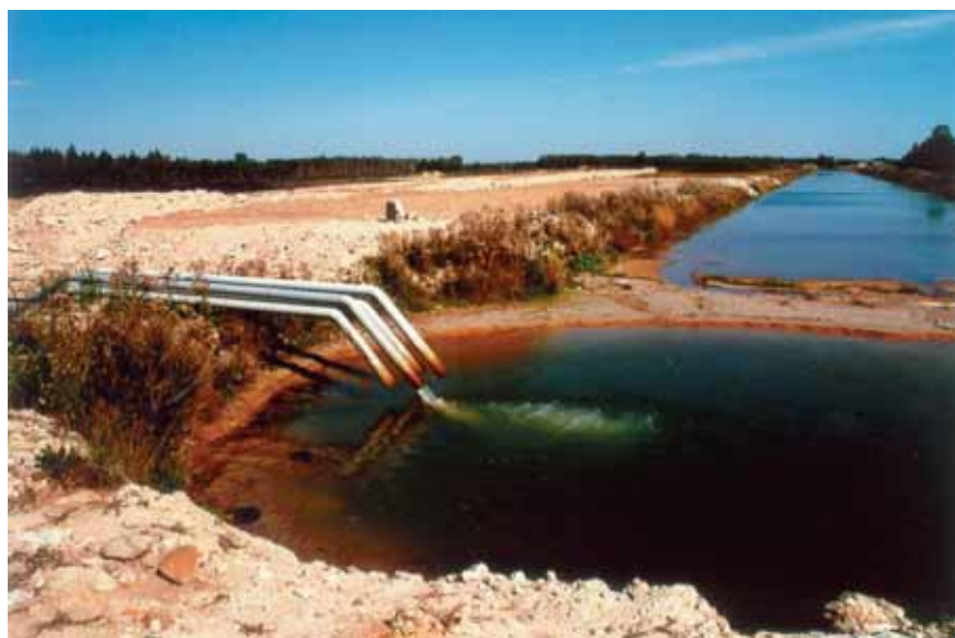
Joonis 3. Pumpade survetorud ja settebassein
