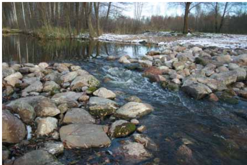
Foto 1. Kaiavere järve väljavoolule rajatud tehiskosk, mis reguleerib järve veetaset ja võimaldab kaladel Amme jões liikuda nii üles- kui ka allavoolu
