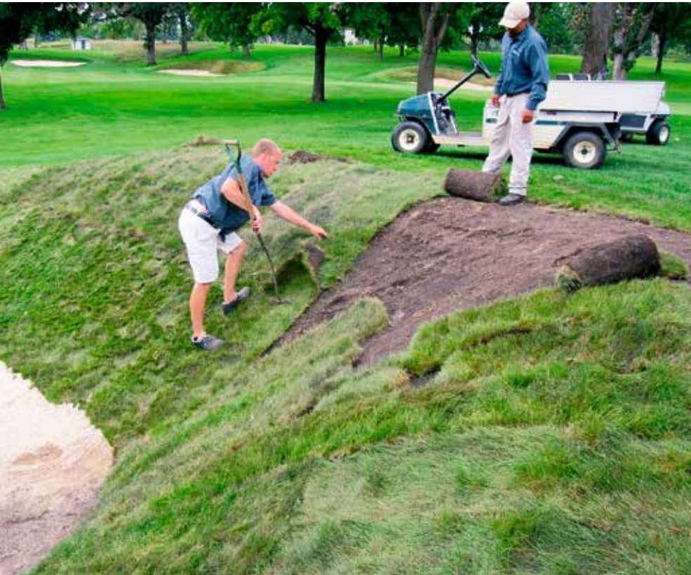
Siirdmuru paigaldamist nõlvale alustage alt üles.
