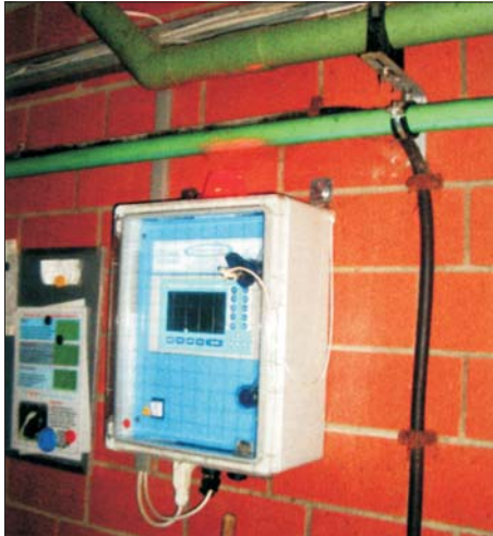
Foto 1. Heatime-süsteemi aju (Die Osnabrücker Schwarzbuntzucht)
