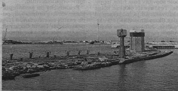
Idamuuli kaldapoolne osa on vee all tugevam kui peal. Esiplaanil normikohane näidistuletorn.
