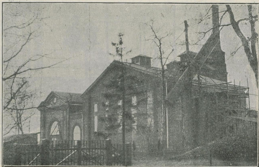
Nr. 19. Esiplaanil uus katlamaja. Näha uue korstna püstitamine.
