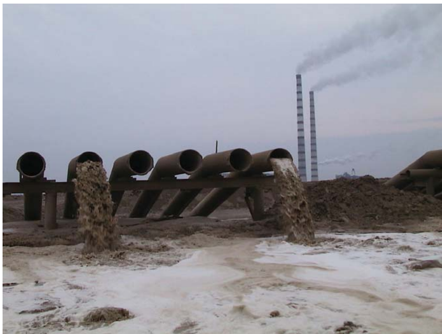
Eesti Elektriijaama tuhaväli. Põlevkivituha jäätmeladestustasu on märksa madalam kui teistel ettevõtetel samasuguste jäätmete ladestamise eest
