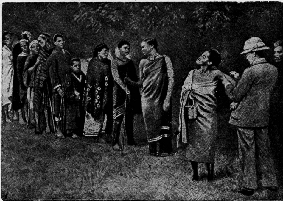
Inglaste poolt alla heidetud Sassa afumaadel Aafrikas. Raitserdugete panemine pärismaalastele.
