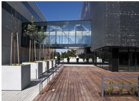
TTÜ Energieetikamaja ja raamatukogu
