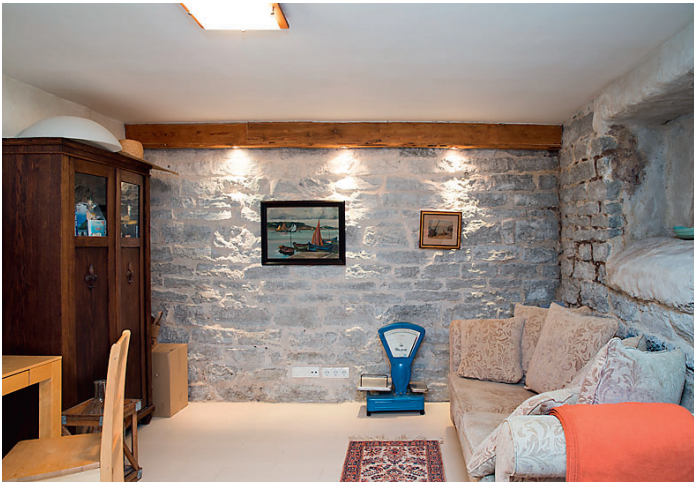
Paekivivundament otsustati vannitoas ja sauna eesruumis mõnes seinas katmata jätta. Enne asus neis ruumides väike katlaruum ja pime moosikelder.
