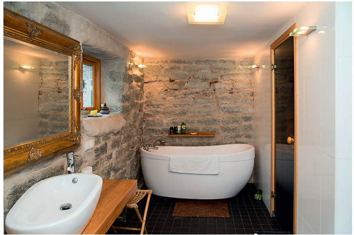
Paekivivundament otsustati vannitoas ja sauna eesruumis mõnes seinas katmata jätta. Enne asus neis ruumides väike katlaruum ja pime moosikelder.
