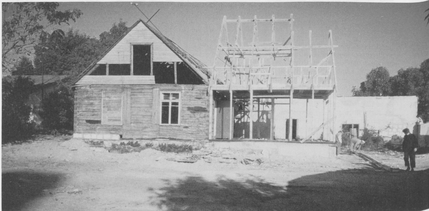
Väedens krog under demontering och renovering, september 1995. Foto Kristina Malmberg.
