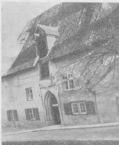
Riddargatan 3, där Revals svenska skola var inrymd — huset i skuggan av den stora, månghundraåriga linden
