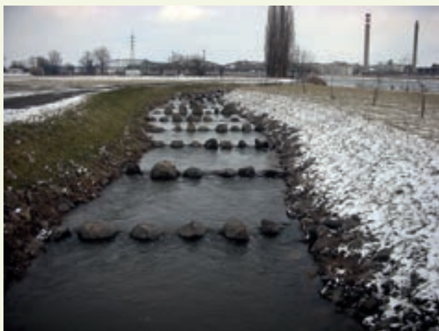
9. foto. Looduslähedane kalapääs, mida kasutavad peamiselt aeglasemad kalaliigid
