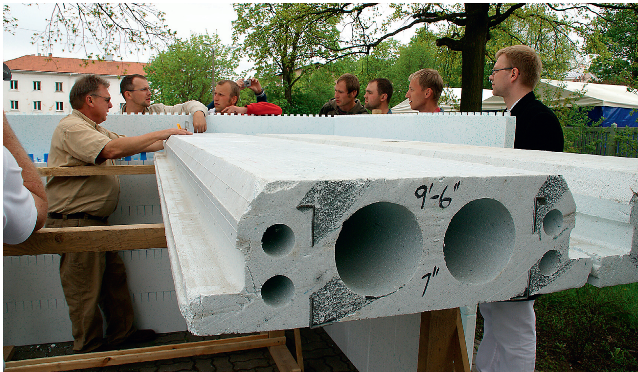
▶ Vahtplastist vorme kasutatakse ka vahelagede ehitamiseks.
