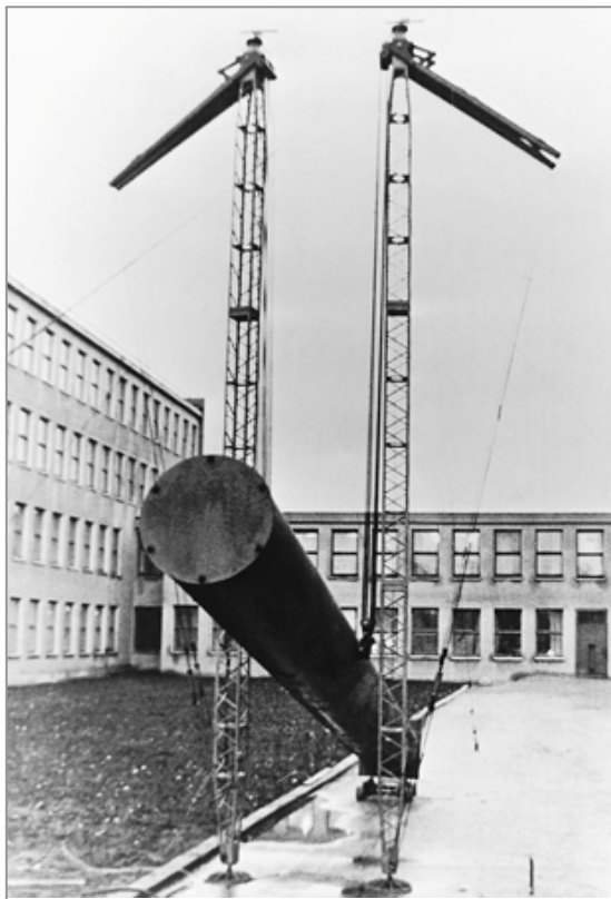
Joonis 4. Mastkraana mudeli katsetamine TTÜ ehitusteaduskonnas.
