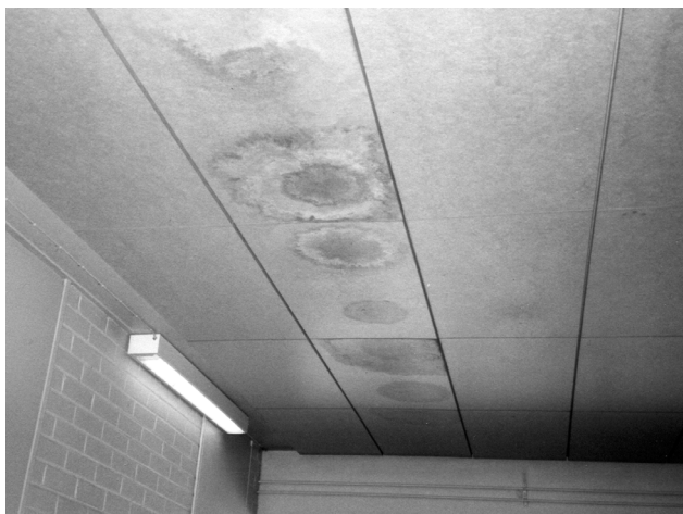
Foto: Kari Vähämäki Lae materjal on märgunud, sellelt võetud külvis kasvas hallitus. Hallituse eosed levivad kergesti ruumi õhku ja tekitavad töötajatele tervisehäireid.
