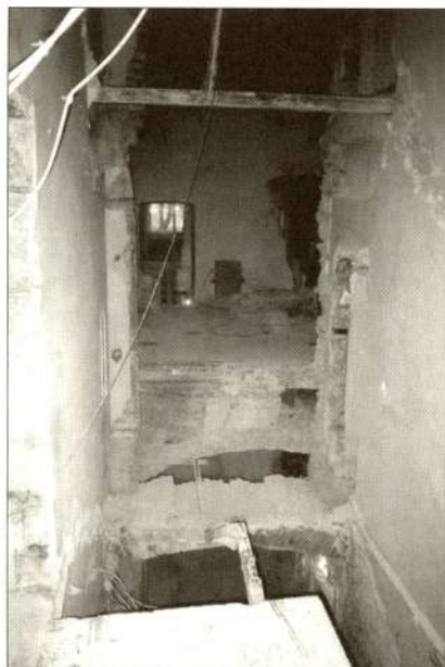
Tallinna KRK renoveerimine 2001. Liftišaht
