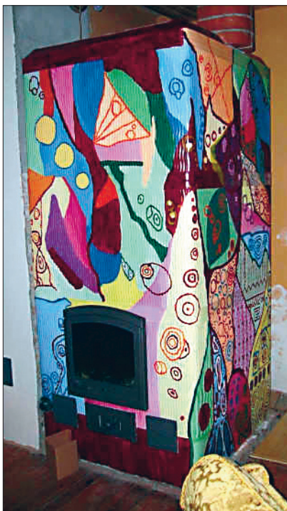
Kividest ehitatud kaminahi on kaetud plekiga ja üle maalitud. Kuna selline ahi kiirgab välja 60-kraadist kuumust, polnud vaja maalimiseks kasutada isegi kuumakindlaid värve.
