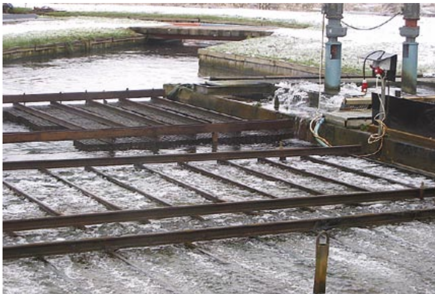
Suletud veekasutusega forellikasvatuse biofilter (Taanis).
