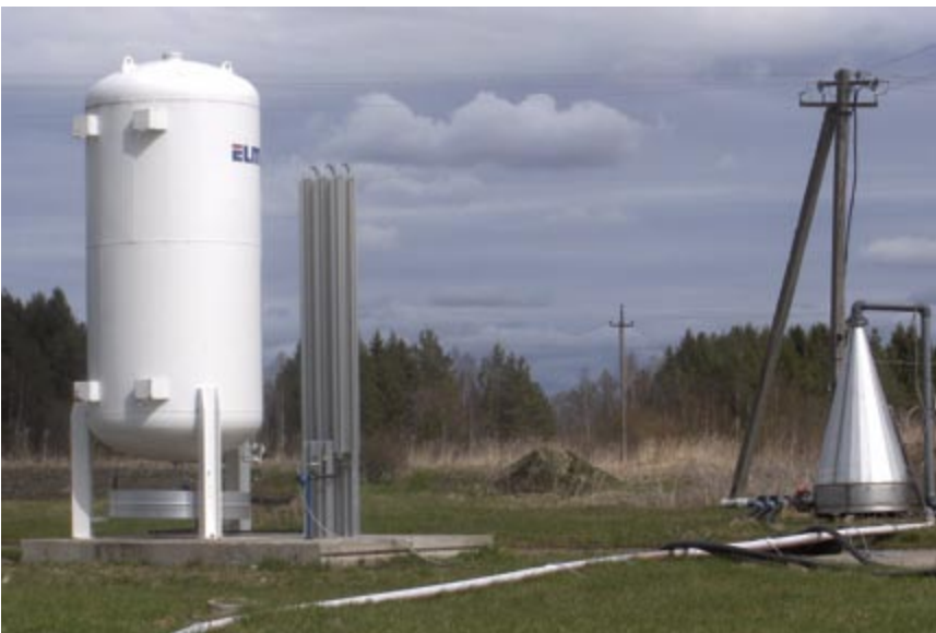
Forellikasvatuses rikastatakse vett puhta hapnikuga.
