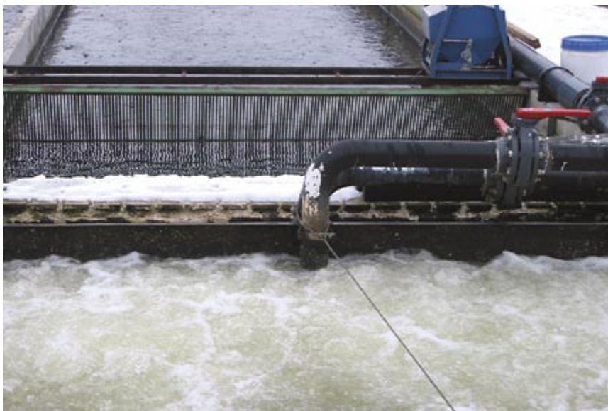
Vee pumpamiseks ja õhutamiseks kasutatakse nn airlifti .
