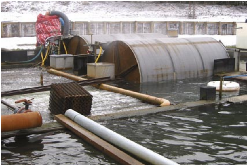
Trummelfilter sette eemaldamiseks forellikasvanduses.
