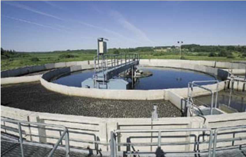
Viljandi reoveepuhasti (bioloogiline puhastus järelsetitiga) foto Peeter Sirge
