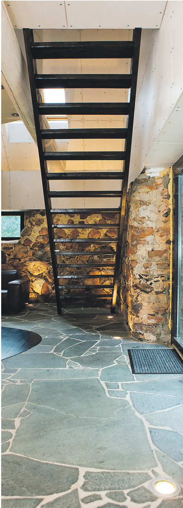
► Suured looduskivist põrandaplaadid toetavad teisele korrusele viivat treppi, mis näeb välja nagu taevaredel.
