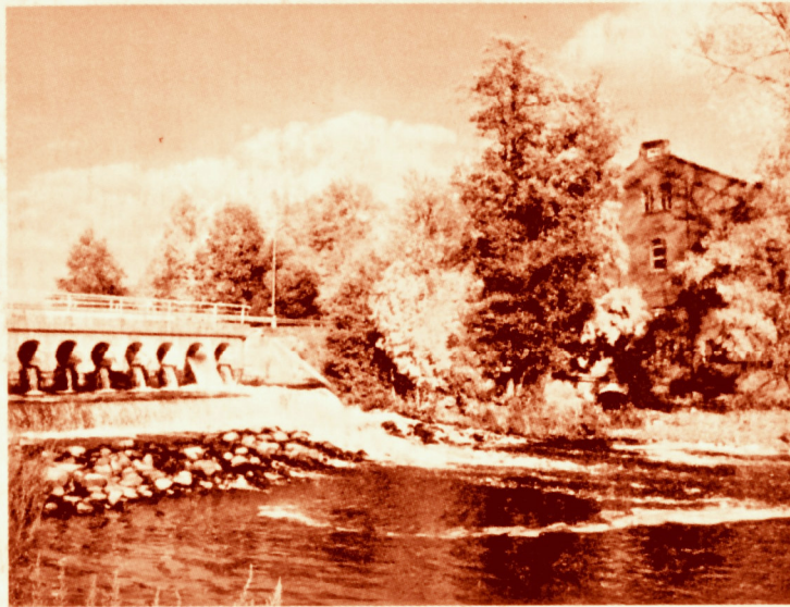
Rõpina hüdroelektrijaam Võhandu jõel
