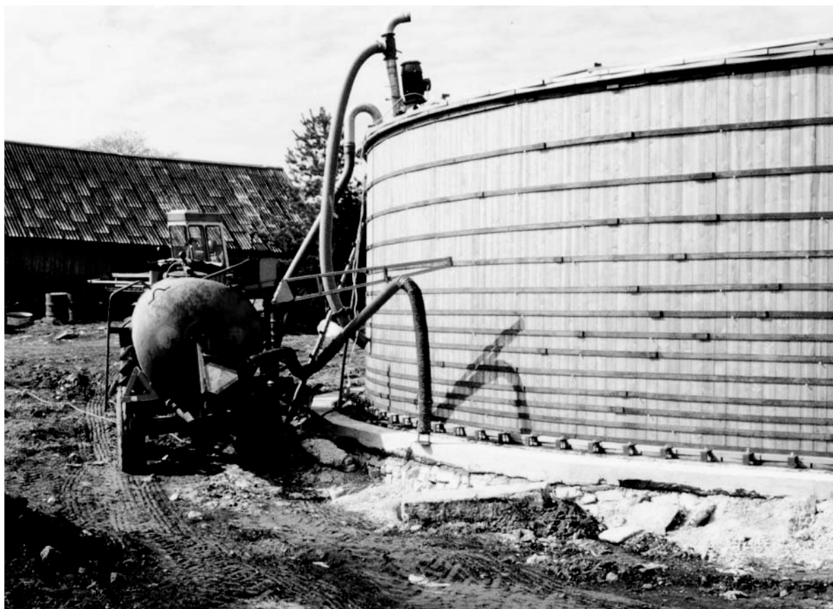
JOONIS 29. PUITSEINTEGA VEDELSÕNNIKUHOIDLA
