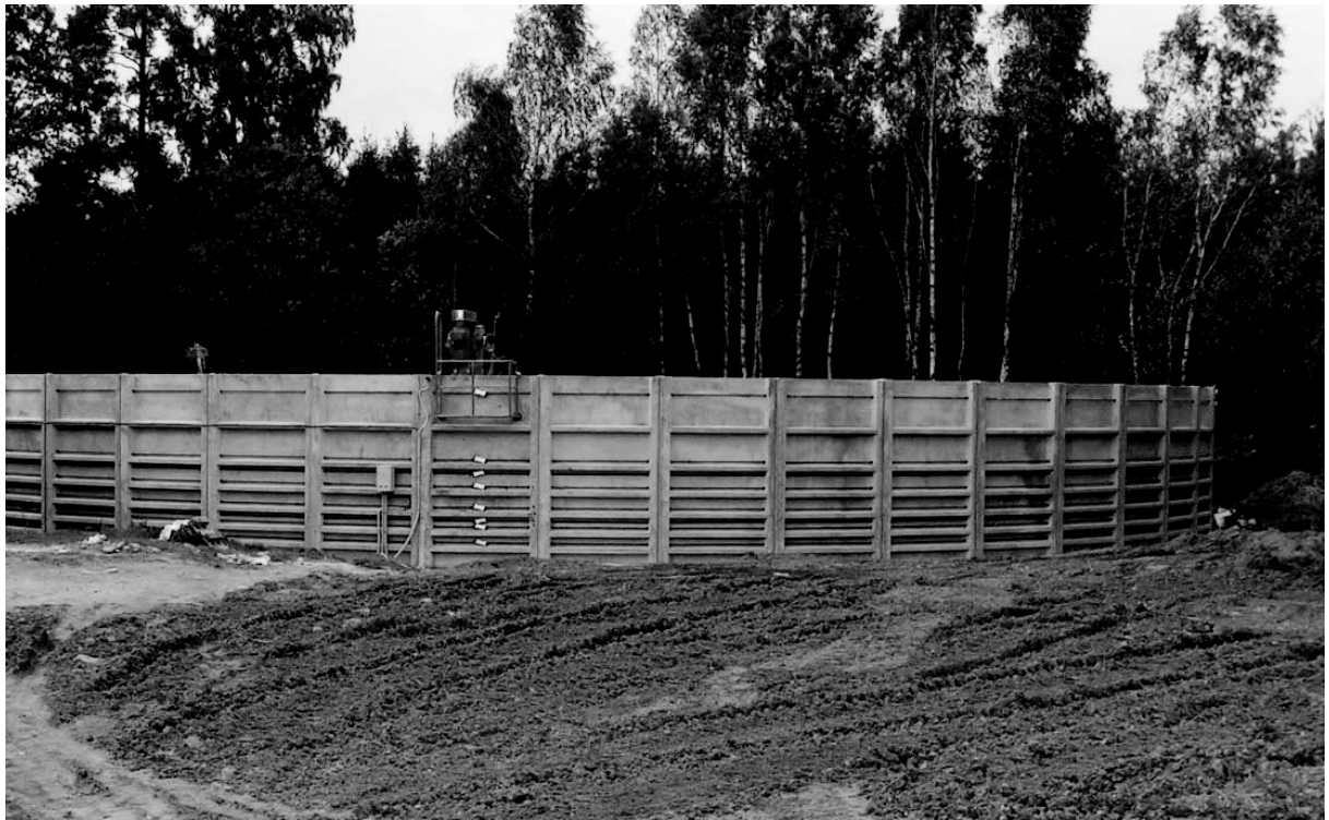
JOONIS 26. ACONTANKSEINAELEMENTIDEST VEDELSÖNNIKU- VÕI VIRTSAHOIDLA
