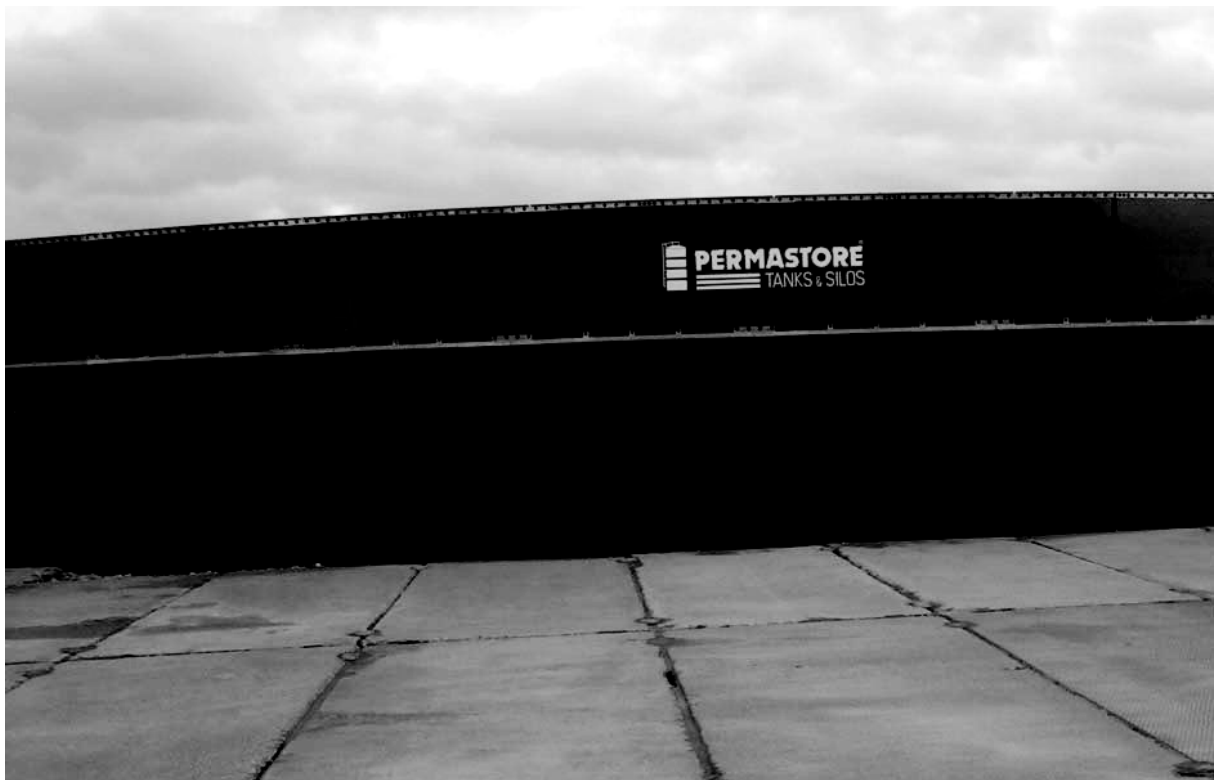
JOONIS 27. EMAILITUD TERASPLAATIDEST SEINTEGA VEDELSÖNNIKUHOIDLA
