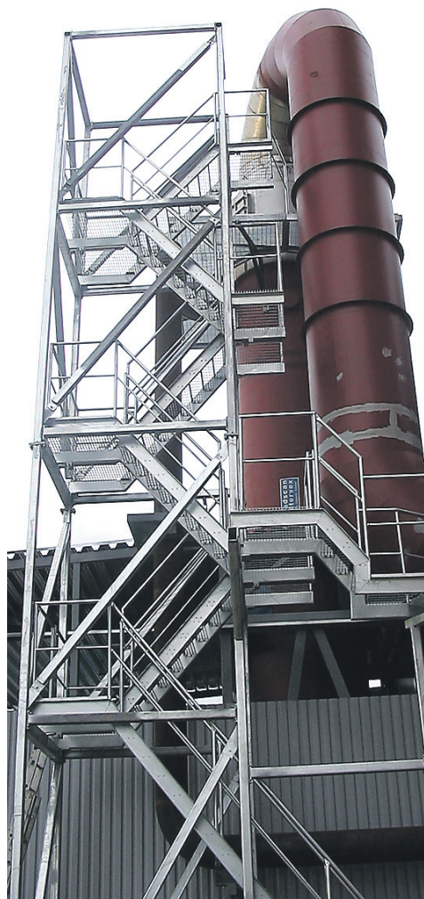
ANNE SOOJUSE terastrepp: materjali saab edukalt kasutada elementides. FOTOD: AS VÖRU HALLID
