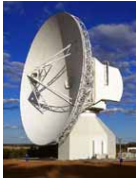
Eesti ettevõtte Vertex valmistab ESA tellimusele Austraallase antennireflektori 35meetrisel läbimõõduga raadioteleskoobile.
