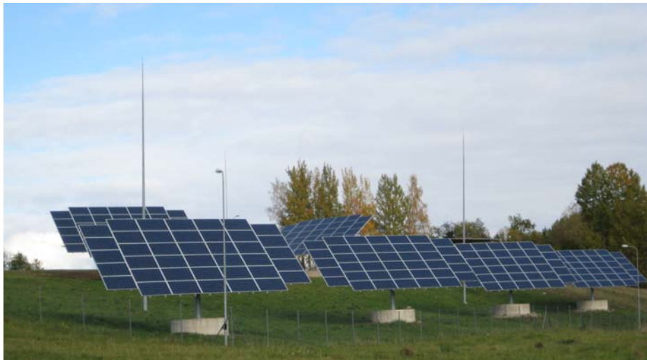
Joonis 6. 11-st energiatornist on alajaama võimsuspiirangu tõttu töös vaid 7 (foto Tiit Kallaste) Figure 6. Out of 11 energy towers 7 only are switched to transformer station due to its' limited capacity (photo by Tiit Kallaste)
