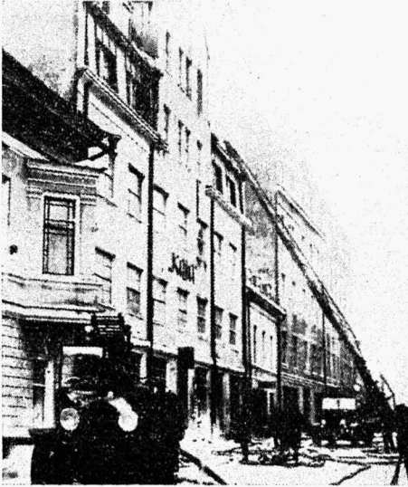
Üldvaade hoonele. Esiplaanil autoprits, taga — autoredel, mille ülemine ots ulatub 5-korrale.
