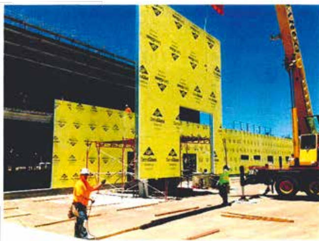
Joonis 9. Monteeritavad välisseinapaneelid
