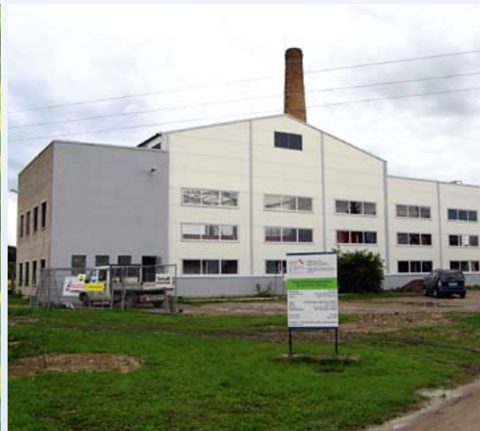
Rohtsel biomassil töötav katlamaja Lihulas
