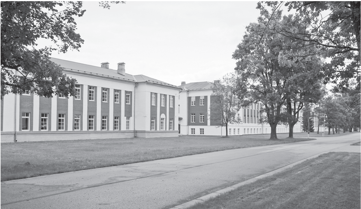
Kuperjanovi jalaväepataljoni renoveeritud hooned
