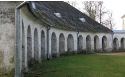
Kiltsi mõisaansambli tiibhoone kaaristu
