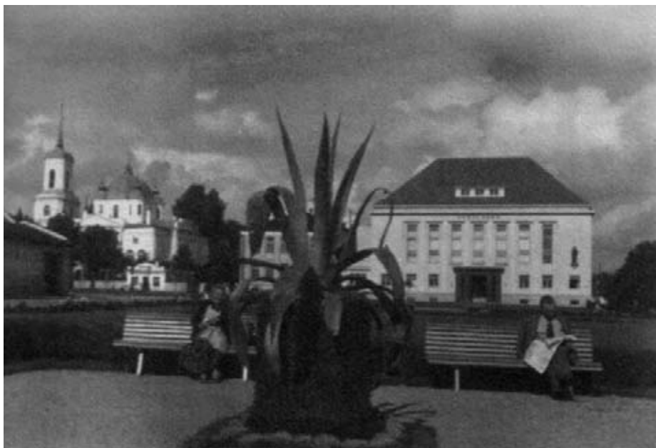
Eesti Panga Tartu hoone esine haljasala. 1938. Tiina Tammeti raamatust "Eesti pargi- ja aiaarhitektuur 1920.-30. aastatel"
