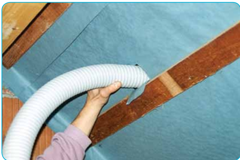
Joonis 5 Tsellulooshelveste puhumine seinakonstruksiooni Allikas: Dämmstatt W.E.R.F. GmbH
