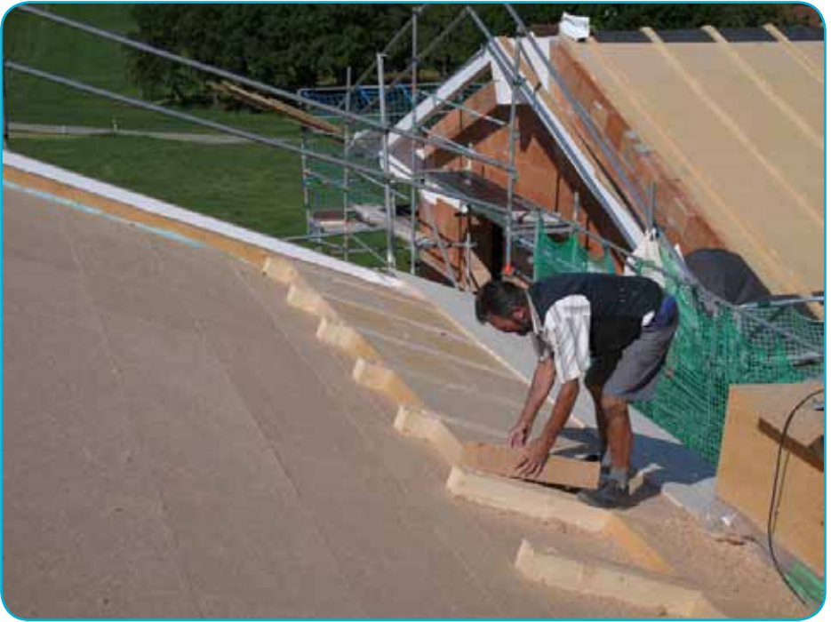
Joonis 7 Puitkiudplaatide paigaldamine katusele | Allikas: PAVATEX
