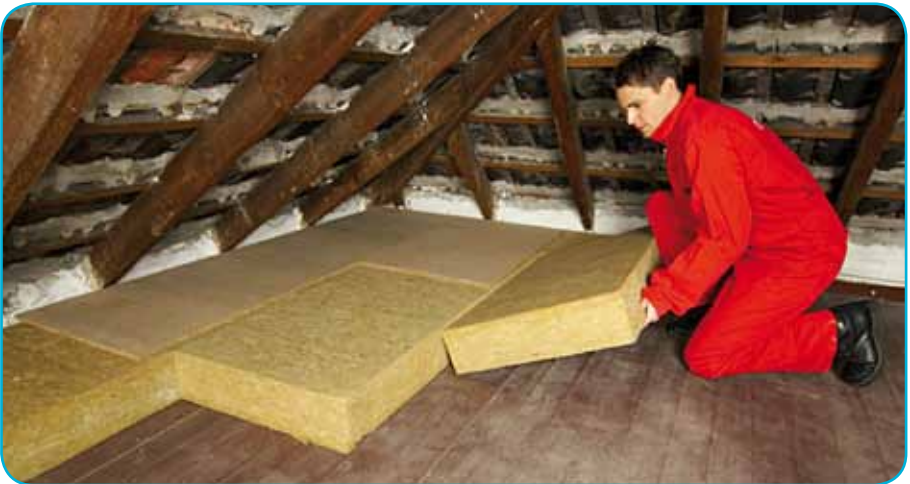
Joonis 3 Kivivilla paigaldamine põõningule
