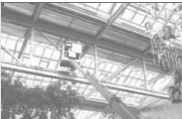
6. näide: Klaasaatriumite ja muude katuste seestpoolt puhastamine rippistmelt (kõite abil liikumine ja kinnitamine)
