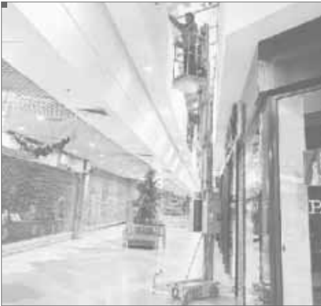
4. näide: Klaasaatriumite ja -katuste seestpoolt puhastamine poomtõstukiga tööplatvormilt
