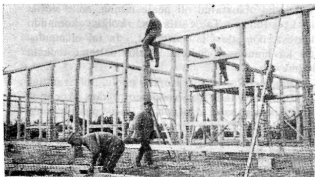
Baraki raamistiku ehitamisel.
