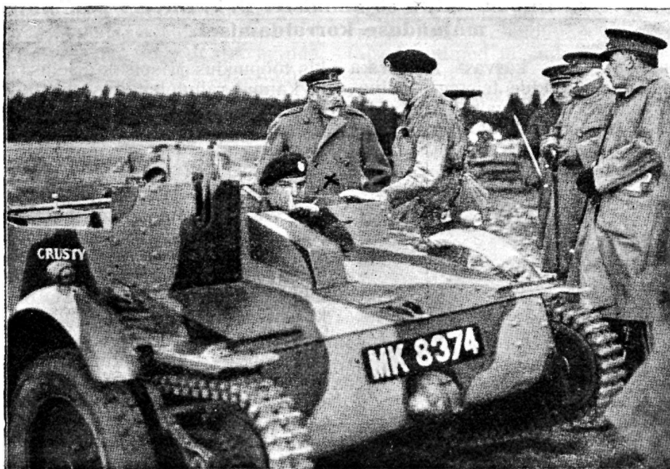
Inglise sõjaväes on tarvitusele võetud uut tüüpi Carden-Lloyd'i kahemehe-tank, n. n. „Crusty“, millega varustatakse mehhaniseeritud pataljone. Mainitud tankidega tehti katseid kuninga (X) juuresolekul k. a. mais Aldershot'is. Pildil kahemehe-tank „Crusty“.
